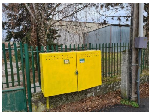
Obr. 5: Meranie spotreby zemného plynu
