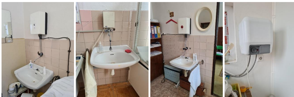
Obr. 15: Elektrické prietokové ohrievače teplej vody
