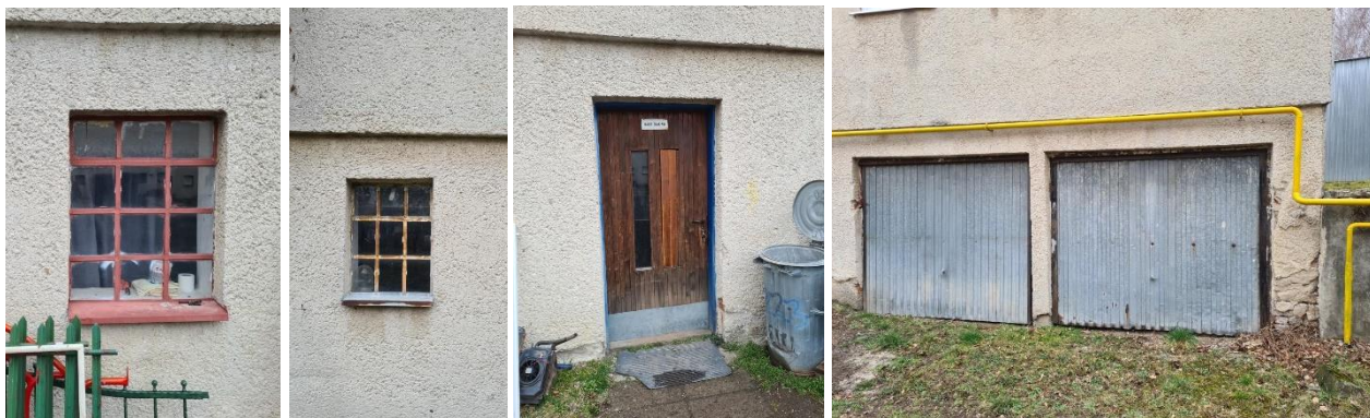
Obr. 12: Otvorové konštrukcie – pôvodné okná, dvere a plechové vráta
