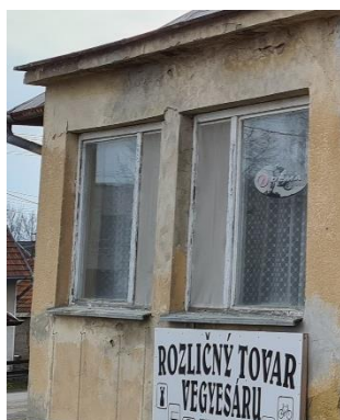
Obr. 11: Otvorové konštrukcie – pôvodné okná
