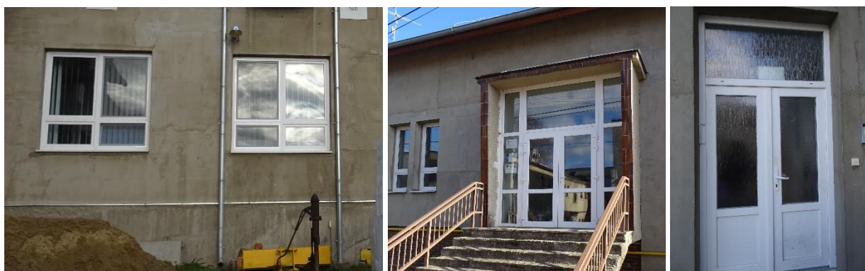
Obr. 12: Otvorové konštrukcie – pôvodné okná a plechové vráta
