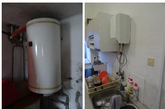
Obr. 18: Elektrický zásobníkový ohrev TV
