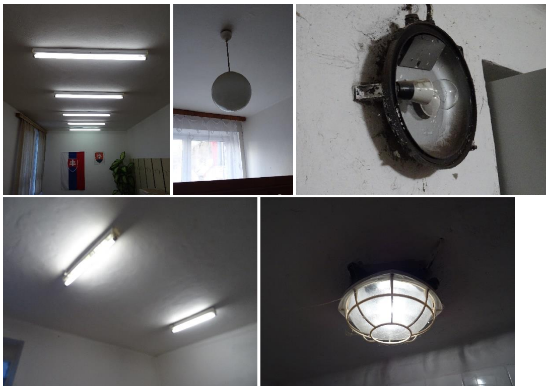
Obr. 20: Typ svietidiel – pôvodné svietidlá s úsporným zdrojom svetla
