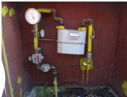
Obr. 5: Meranie spotreby zemného plynu
