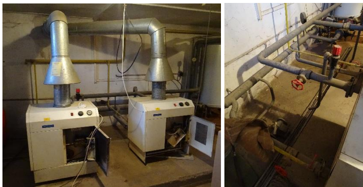
Obr. 14: Vyvedenie tepla zo zdroja tepla
