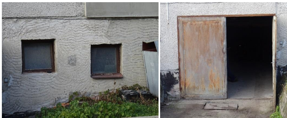
Obr. 12: Otvorové konštrukcie – pôvodné okná a plechové vráta
