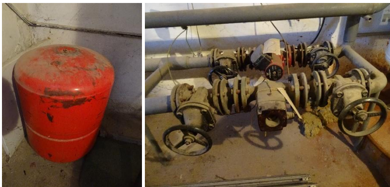
Obr. 15: Expanzná nádoba a obehové čerpadlá
