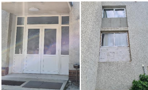
Obr. 10: Otvorové konštrukcie – vymenené okná a dvere s plastovým rámom a izolačným dvojsklom
