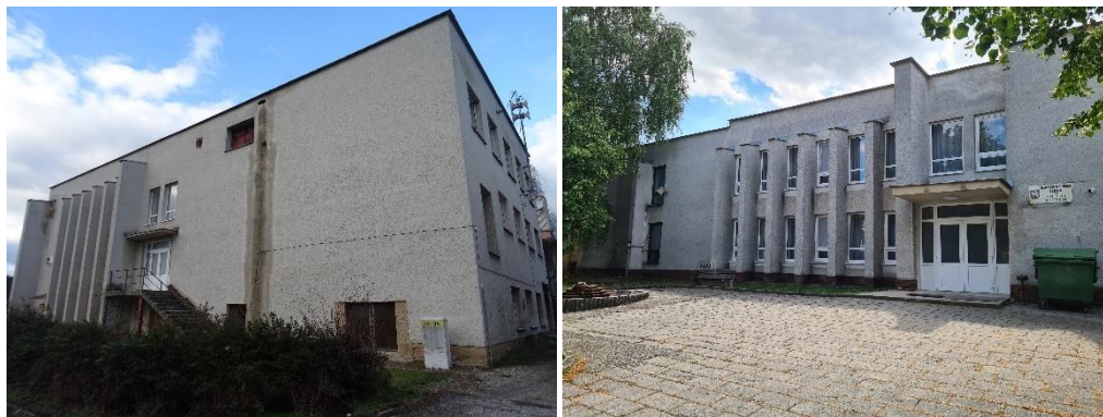
Obr. 6: Kultúrny dom, Plášťovce – západný a severný pohľad
