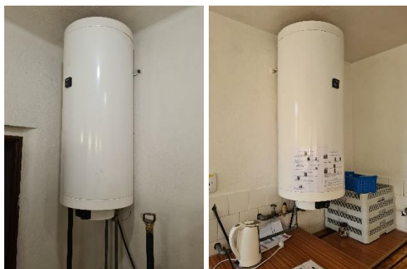
Obr. 14: Elektrické zásobníkové ohrievače teplej vody
