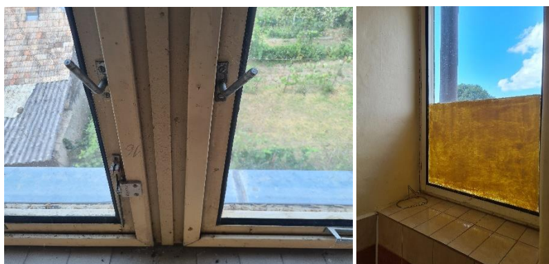
Obr. 11: Otvorové konštrukcie – pôvodné okná
